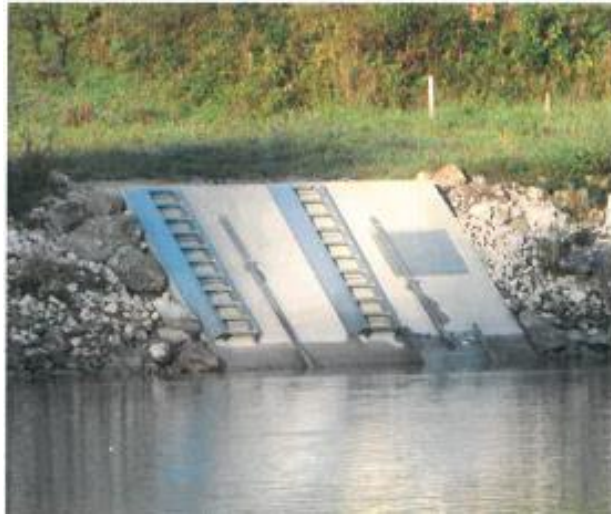
Entnahmehauwerk am Ufer des Inn, Quelle: Duschl
